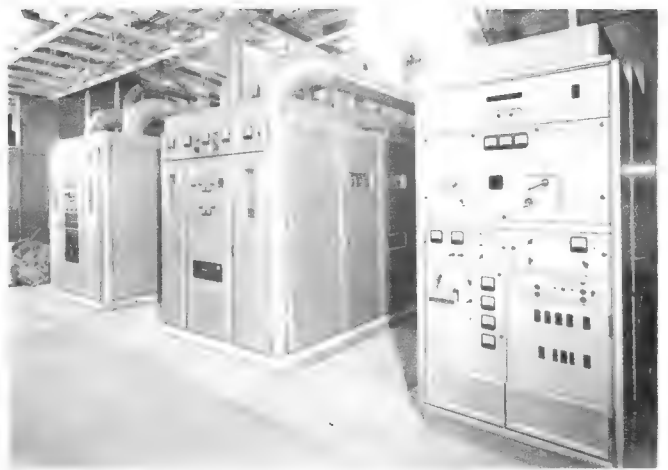
Bild 3. Senderfront des 250-kW-Kurzwellensenders, bestimmt für die Relaisstation Kigali (Marconi). Von links nach rechts: Modulationseinheit, Hf-Einheit, Steuersender
